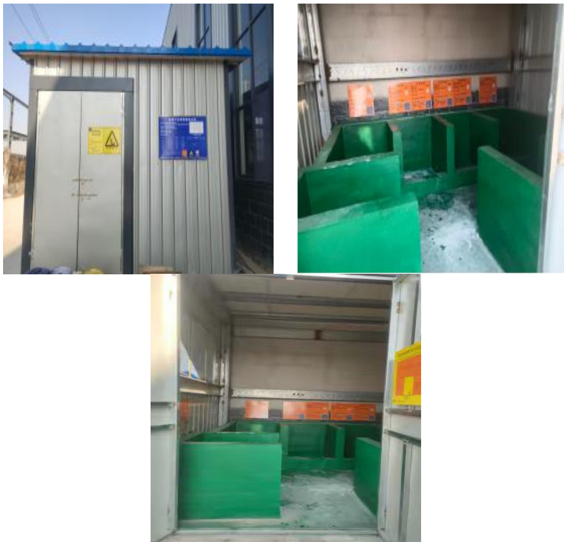
图 3-2 危废暂存间现状图
