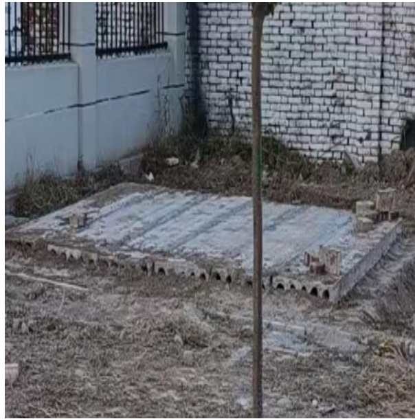
图 3-3 现场事故水池
