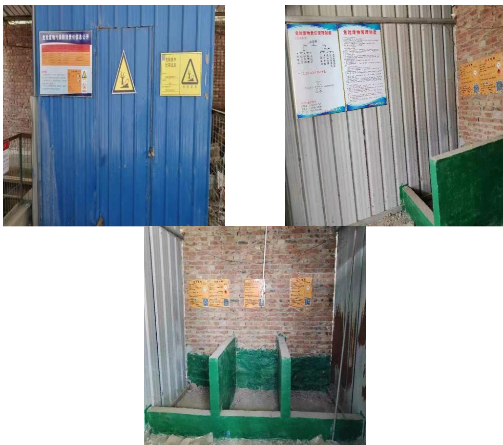
图 3-2 危废暂存间现状图
