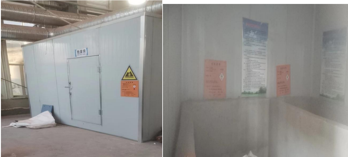
危废暂存间照片
