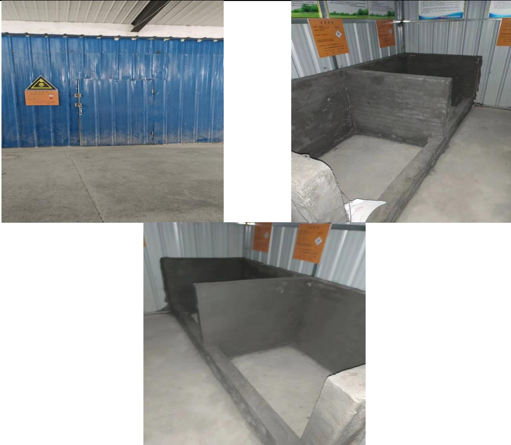
图 3-2 危废暂存间现状图
